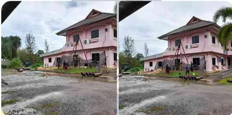
๑๔. โครงการก่อสร้างต่อเติมอาคารสำนักงาน อบต.ทุ่งมะพร้าว
